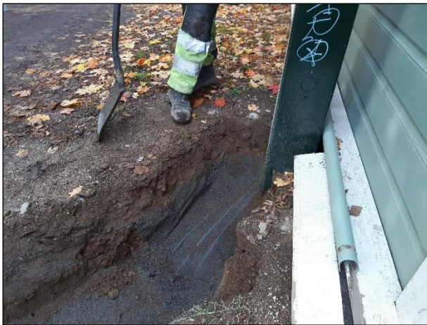
Vasen. Aikaisemmin kaivetut kaapelit on otettu esiin. Oikea. Luoteiskulman kaivantoa syvennetään ja multamaata poistetaan.
