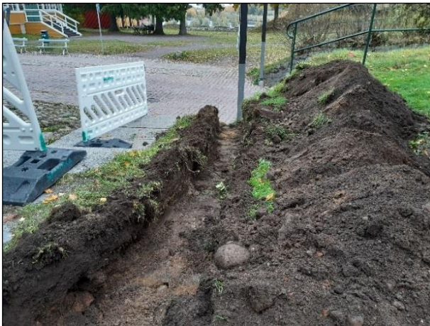
Vasen. Kaapelioja kaivettu länteen Kristiinankadulle. Oikea. Pieni erillinen pätkä kaapeliojaa.
