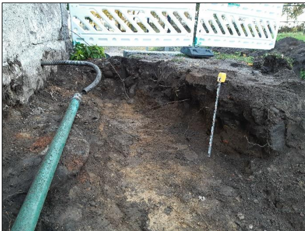
Vasen. Hiekkamaan pinta saatu esille lähellä kaakkoiskulmaa. Oikea. Hiekka tuli esiin vasta syvemmällä lähellä rakennuksen lounaiskulmaa ja alueelta jouduttiin poistamaan suurehkoja kiviä, jotka eivät muodostaneet mitään rakennetta, vaan ilmeisesti kiviä oli kasattu sadevesien takia.
