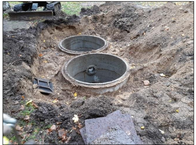
Vasen. Ensimmäistä kaivoa otetaan esiin. Oikea. Molemmat kaivot esillä ja kannet poistettuna.
