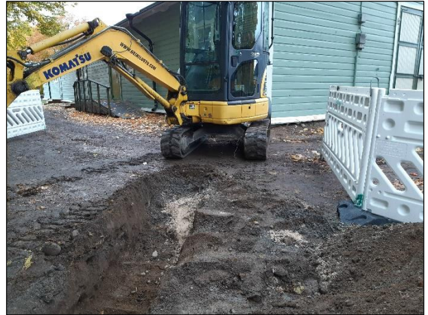
Vasen. Kaapeliojan kaivuutyö alku lähellä rakennuksen luoteisnurkkaa. Oikea. Kaapeliojaa kaivetaan kohti luoteessa olevan rakennuksen kulmaa.
