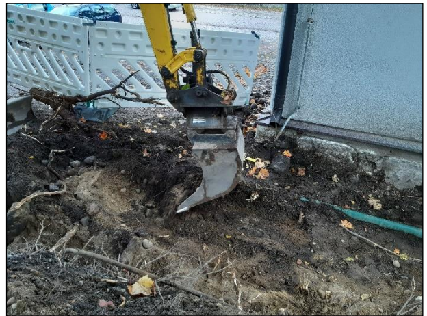
Vasen. Aikaisemmin kaivetut kaapelit on otettu esiin. Oikea. Luoteiskulman kaivantoa syvennetään ja multamaata poistetaan.
