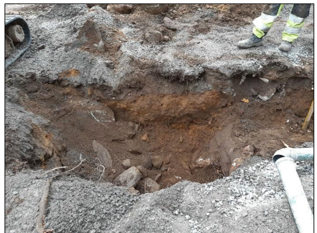
Vasen. Kaivuutyön viimeistelyä länsiseinustalla. Oikea. Sadevesikaivon paikka rakennuksen lounaiskulmalla, eteläseinusta on tuettu kivimurskeella.
