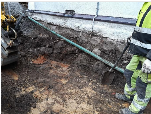
Vasen. Kaivuutyön viimeistelyä länsiseinustalla. Oikea. Sadevesikaivon paikka rakennuksen lounaiskulmalla, eteläseinusta on tuettu kivimurskeella.
