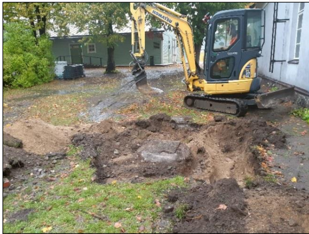
Vasen. Ensimmäistä kaivoa otetaan esiin. Oikea. Molemmat kaivot esillä ja kannet poistettuna.
