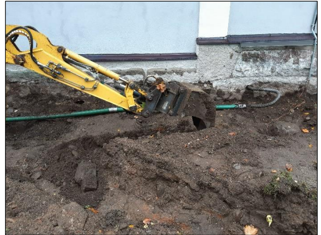
Vasen. Kaapeleita esillä rakennuksen länsiseinustalla. Oikea. Kaivantoa syvennetään ja multakerroksia poistetaan rakennuksen eteläpäädyssä.
